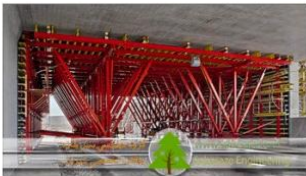
(سیستم قالب تونلی)
