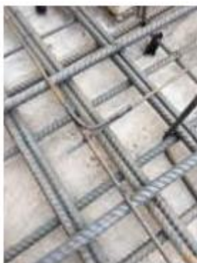
جوشکاری میلگردهای شناژ با شالوده به ستون:
